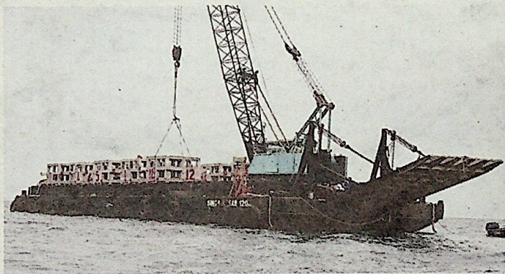
KERJA-KERJA menurunkan tukun untuk dibenamkan ke dasar laut Tok Bali, Pasir Puteh, Kelantan. - UTUSAN/TOREK SULONG
