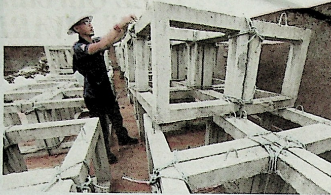
PEKERJA memeriksa tukun konkrit sebelum ditenggelamkan di perairan Kampung Mukut, Pulau Tioman menggunakan tongkang.
