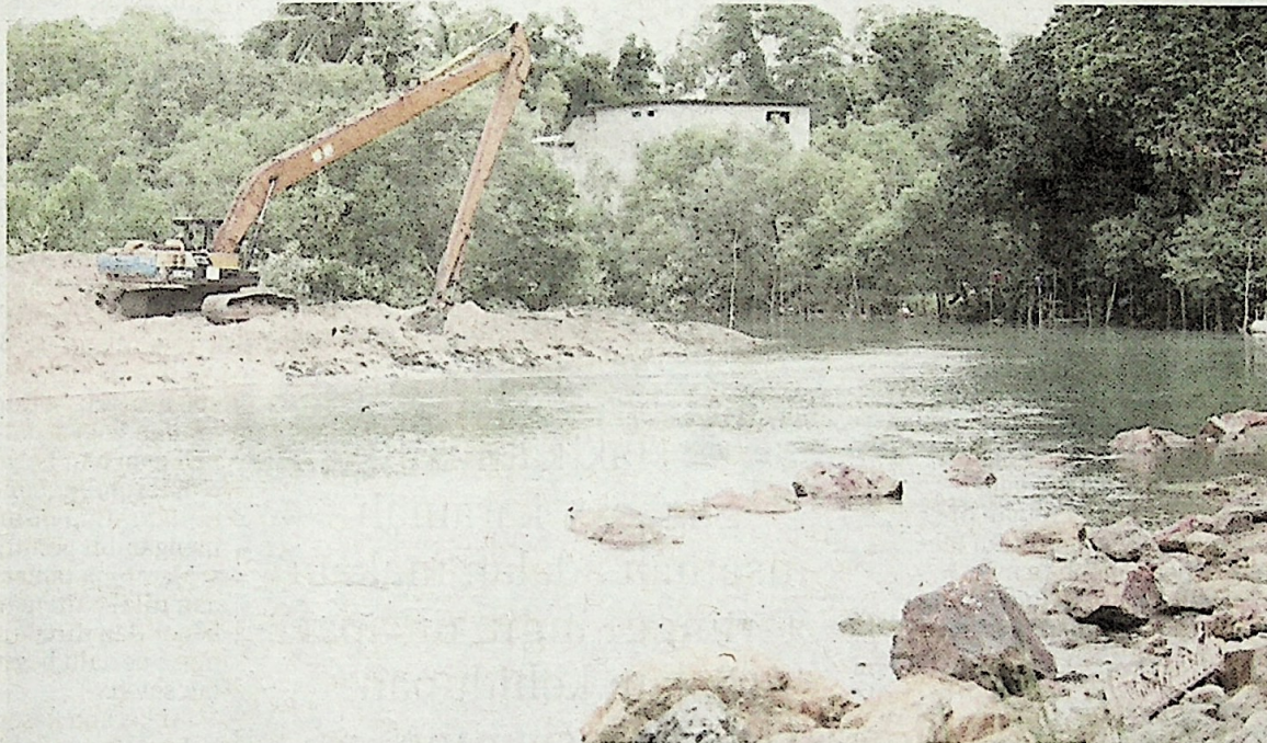
KERJA mendalam dan melebarkan muara Sungai Tering Kampung Tanjung Batu giat dijalankan.
