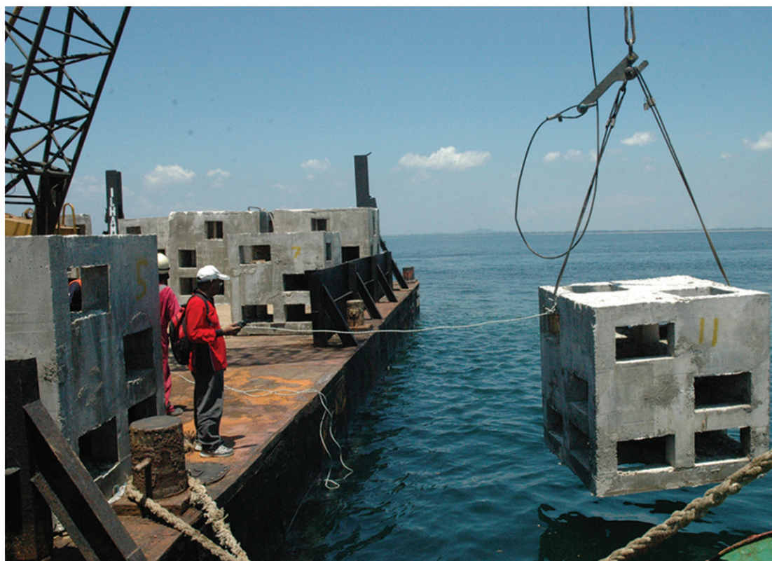
Gambar 37A: Proses Melabuh Tukun Konkrit Menggunakan Peranti
