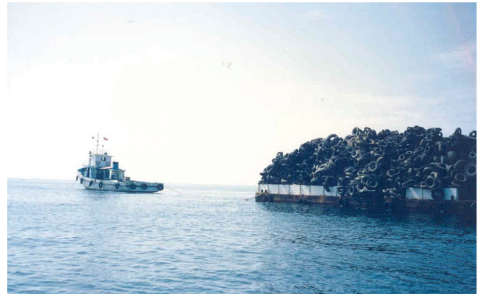
Gambar 17: Proses Mengangkut Tukun Tayar ke Lokasi
